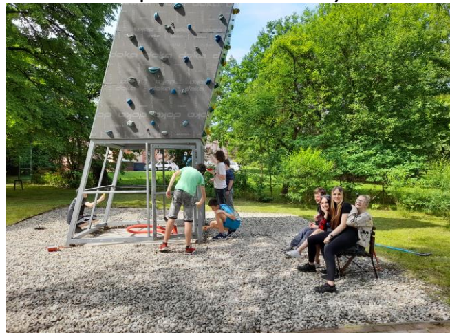
Oprava lezecké stěny
